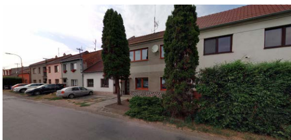
Původní sevřená řadová zástavba (ul. Husova)
